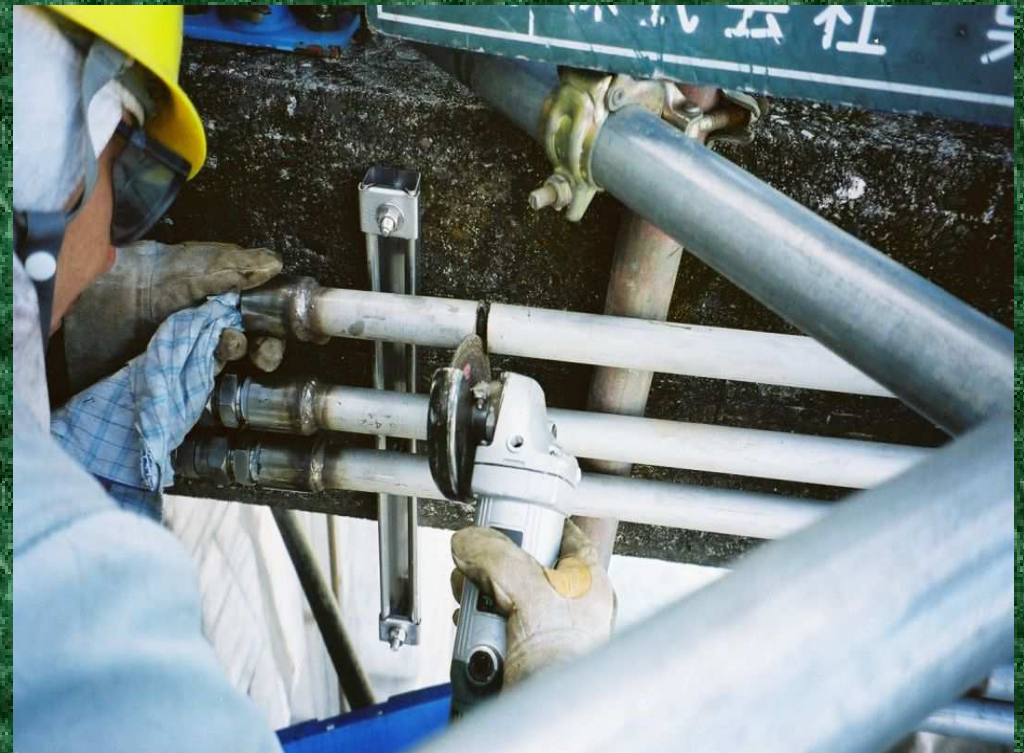
写5-3 配管の切断
