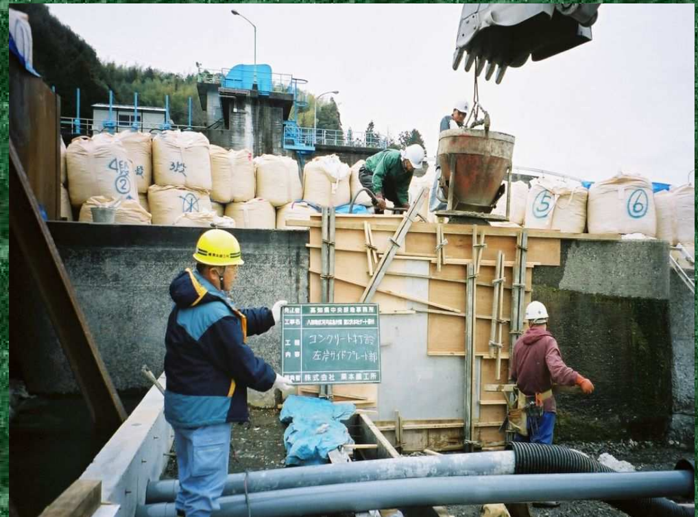
写6 二次コンクリート打設
