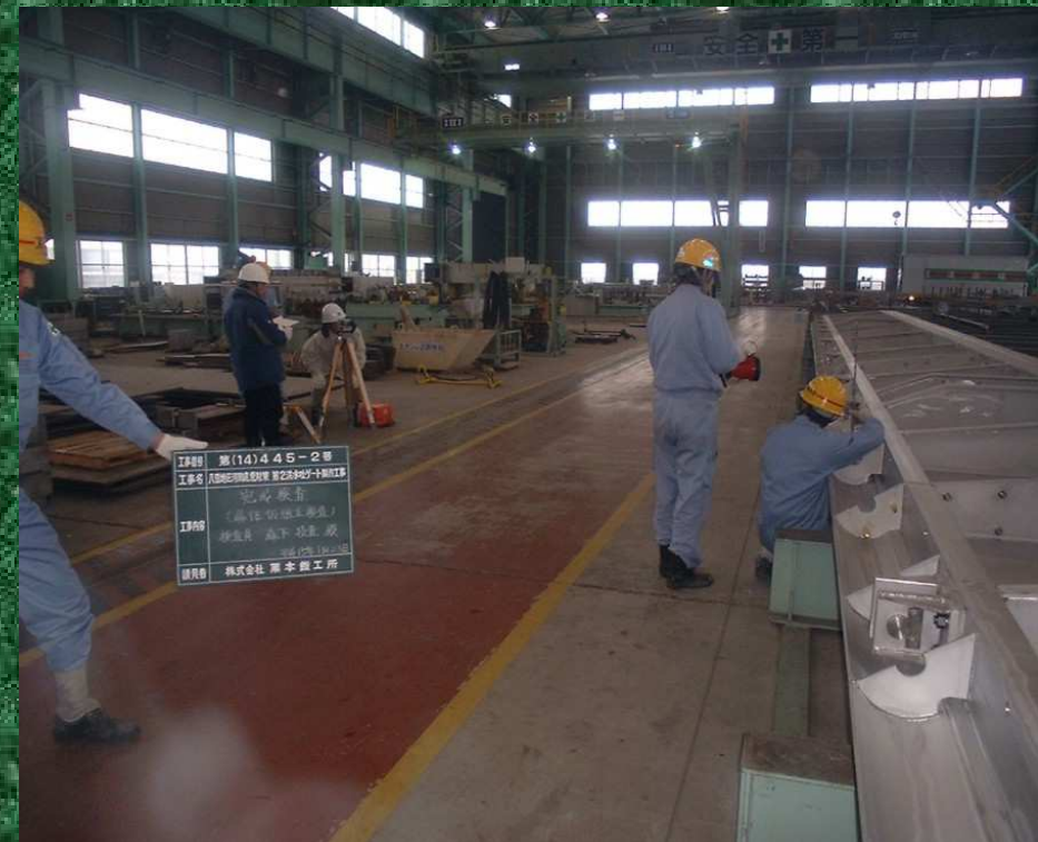
写6-6 御立会検査(扉体レベル)
