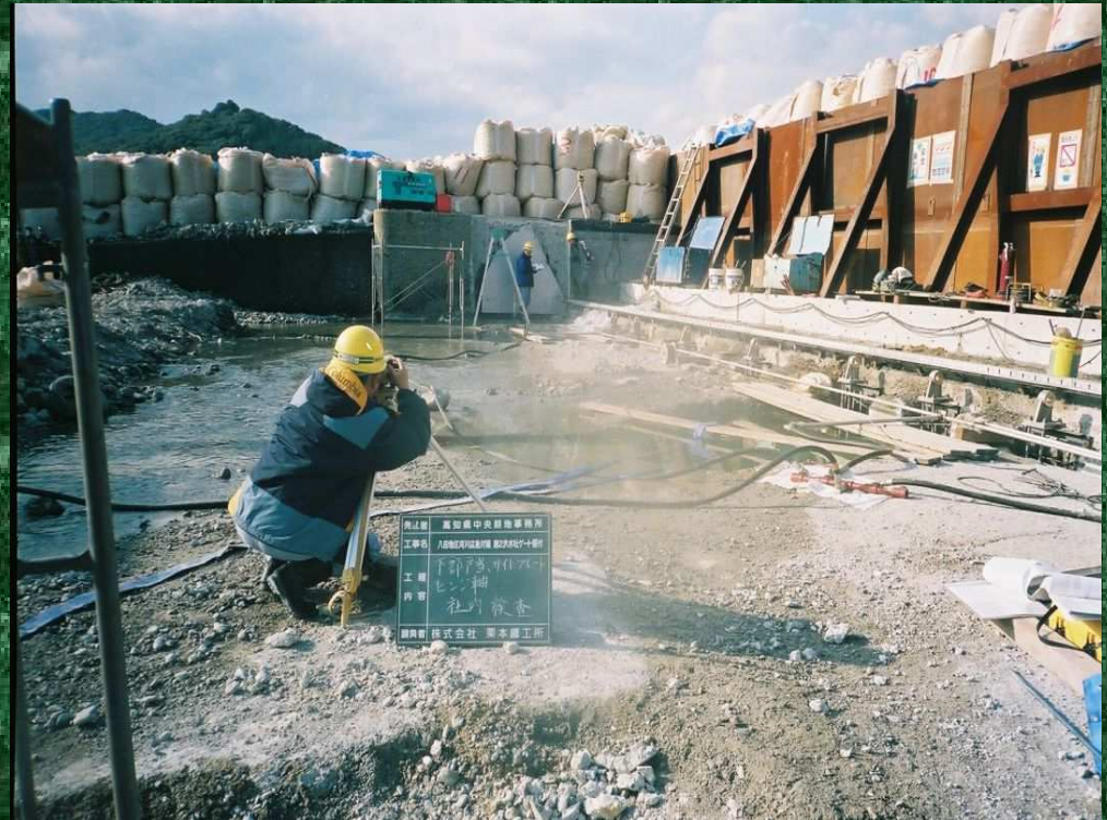
写4-4 社内検査(下部戸当り・ヒンジ軸受据付確認)
