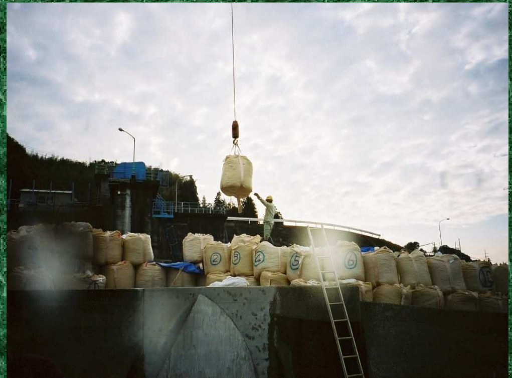
写1-2 仮締切設置中
