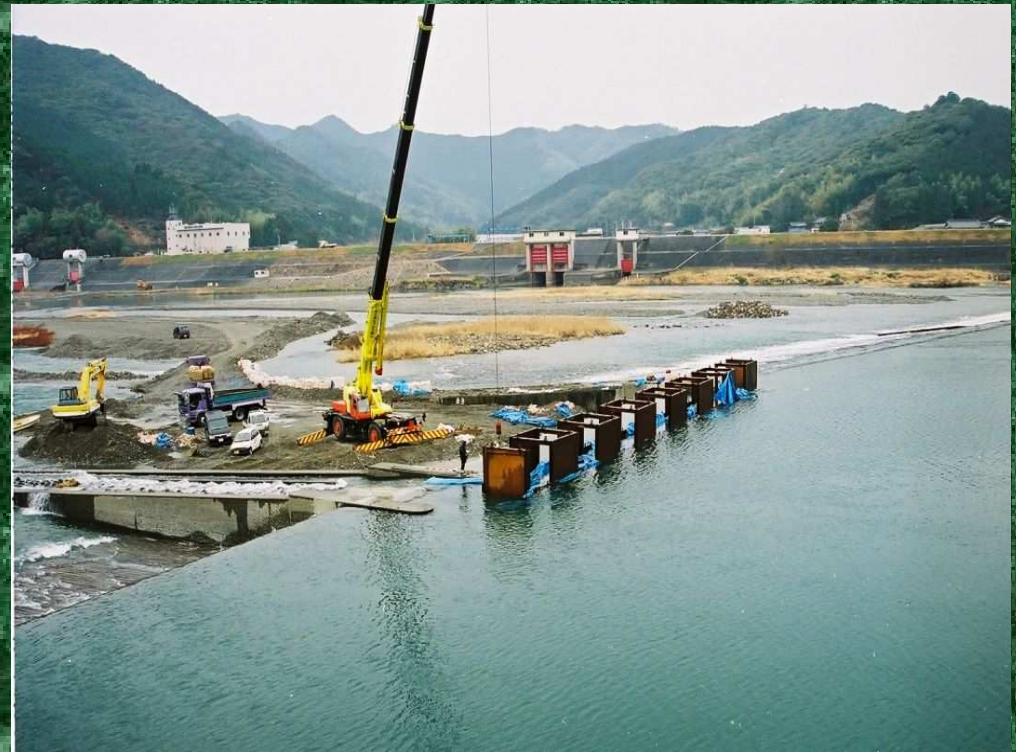
写1-1 仮締切設置中
